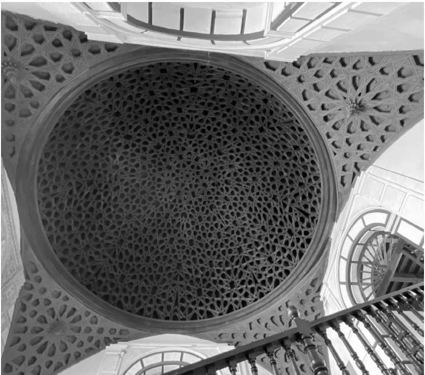
Cubierta de media naranja de la caja de escalera del claustro del convento de San Francisco de Lima.
