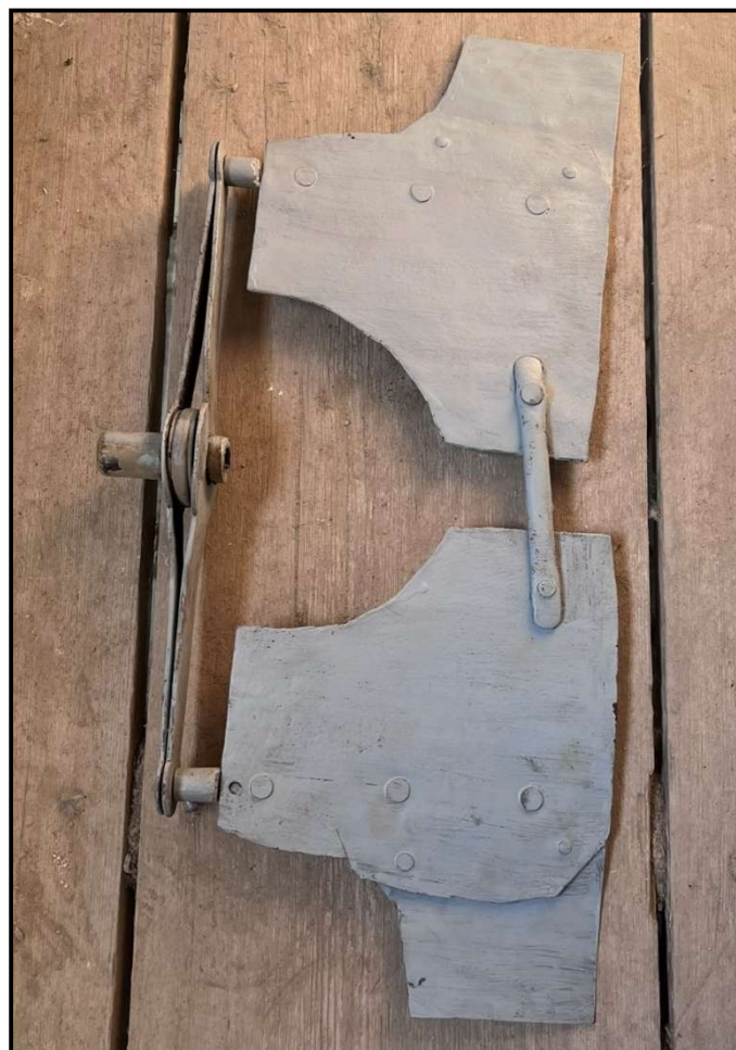
Figura 41: Venterol de los cuartos desmontado. Fuente: propia
