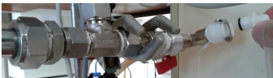
Figura 47 Reactor tubular. Detalle de la conexión de retorno
