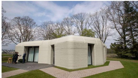
Figura 15. Primera casa impresa en 3D de modo integro [40].
