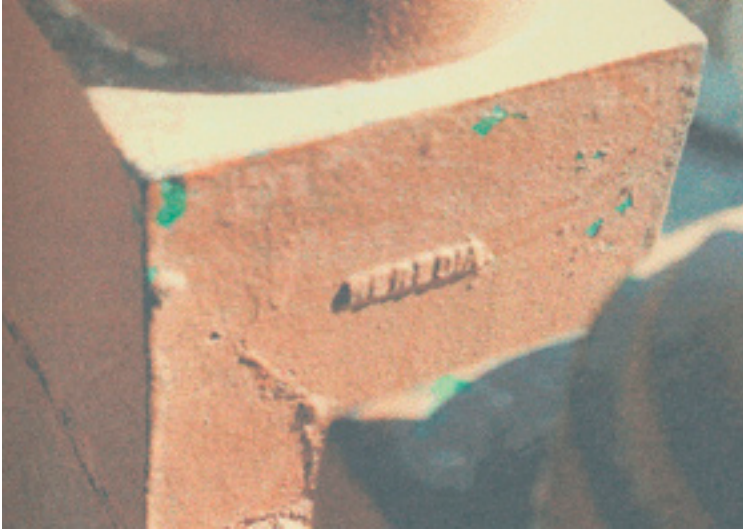
Fig. 15: Sello de la fundición de Heredia en la base de los balaustres de la azotea. Tomada de PÉREZ BERNAL, P. F.
