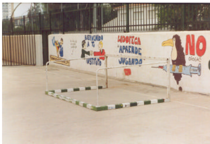
Portería sin anclar. I.E.S. "Guadalmedina". Málaga.
