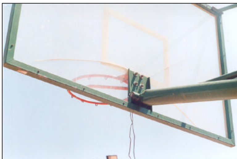
Aro. Transmisión de fuerza al tablero. I.E.S. "Sierra Bermeja". Málaga.
