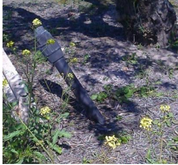
Ilustración 24. Válvula de descarga
