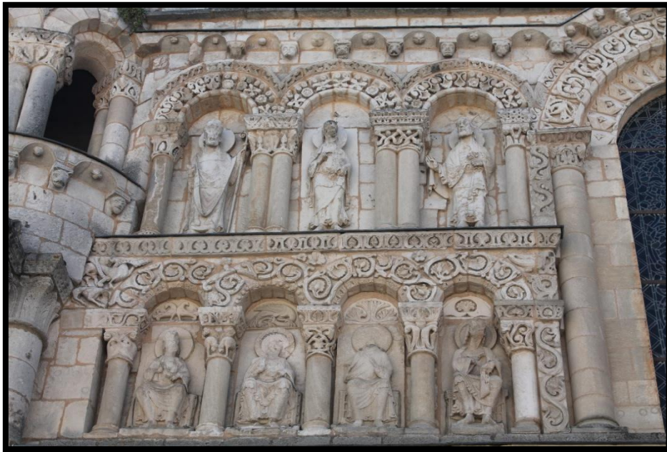
Lámina 19. Detalle. Arcadas superiores de izquierda a derecha: un papa, un apóstol y San Pedro. Arcadas inferiores: cuatro apóstoles.
