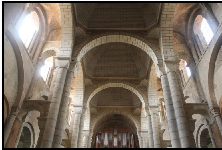
Figura 10. Bóveda central iluminada por vanos Ubicación: Saint-Hilaire-le-Grand (Poitiers) Fuente: fotografía de la autora (Junio 2017)
