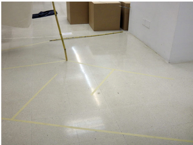
Cintas indicando los espacios internos.
