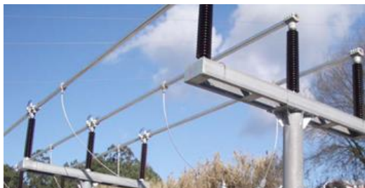
FIGURA 15 EMBARRADO RÍGIDO CONDUCTOR TUBO AL
