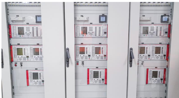
FIGURA 111 ARMARIO UCP FUENTE: INGTEAM.
