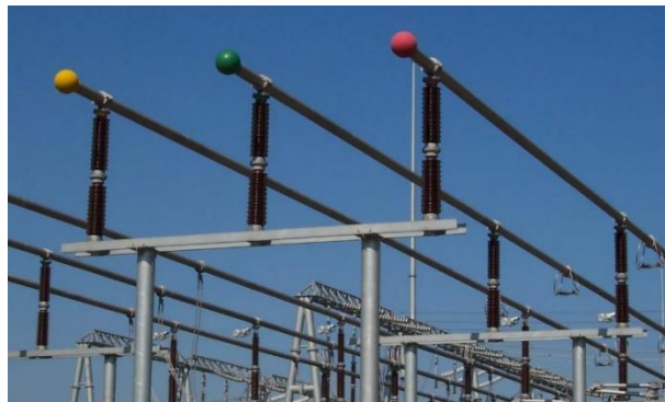
FIGURA 23 AISLADORES EMBARRADO
