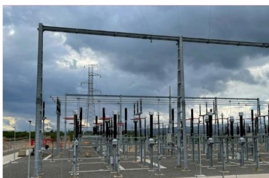
FIGURA 5 PÓRTICO ENTRADA
