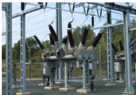
FIGURA 25 MÓDULO HÍBRIDO
