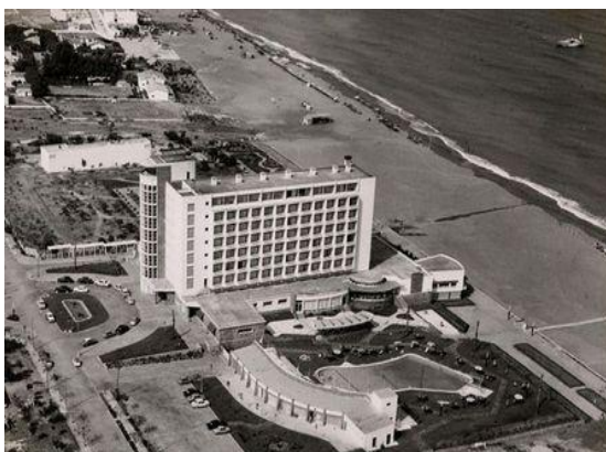
Foto 4. Hotel Pez Espada . Torremolinos. Imagen antigua del Hotel facilitada por Antonio Olaya. Imagen tomada del sitio: www.torremolinoschic.com (Fecha de actualización: 11 de Junio de 2014).
