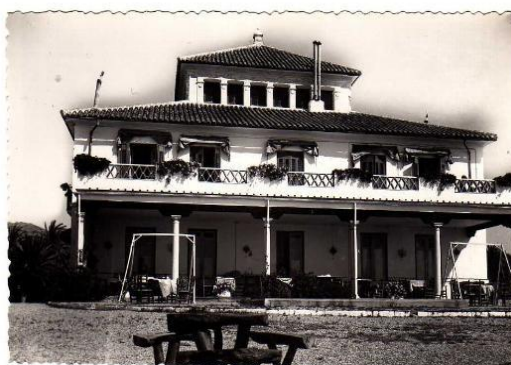
Foto 1. Hotel La Roca (Torremolinos). Fachada al mar. Imagen tomada del sitio: www.historiadetorremolinos.com (Fecha de actualización: 11 de Junio de 2014).
