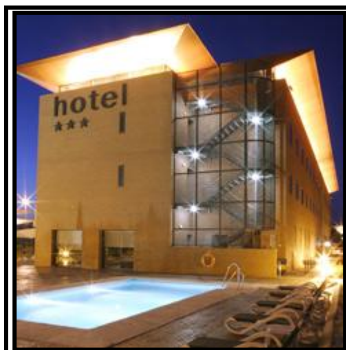
Foto 44. Hotel Posadas de España. Piscina del hotel. Imagen tomada del sitio: www.posadasdeespanamalaga.com (Fecha de actualización: 17 de Junio de 2014).
