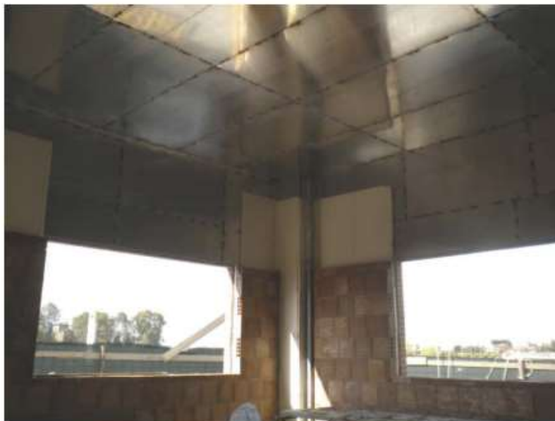
Figura 2. 18. Imagen de recubrimiento de edificio mediante placas conductoras. Fuente: Bavastro et al. 2015
