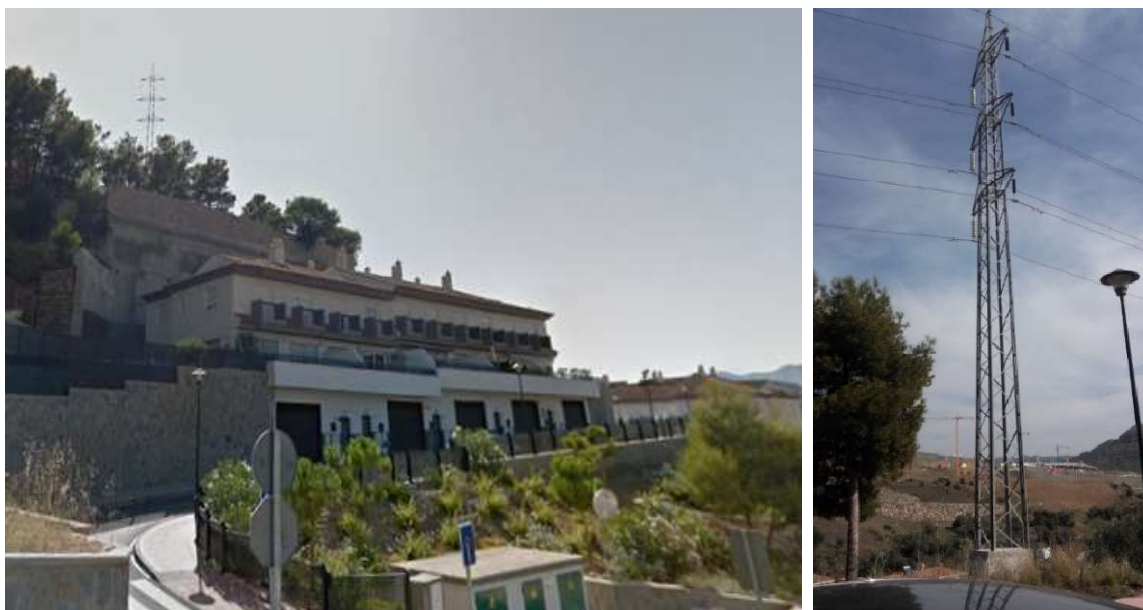
Figura 5.3. Detalles de la línea eléctrica “Montes-Centro”
