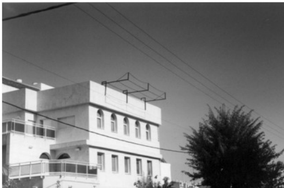
Figura 2. 20. Bucle de compensación activa instalado en la cubierta en un edificio. Fuente: Shenkman et al., 2005
