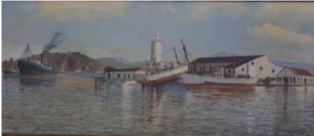
Años 40. Edificio de Salvamento de Náufragos, astilleros y Sanidad Marítima coronados por la Farola y San Antón al fondo, eran los elementos que en esa época conformaban el extremo sur del Muelle Viejo, y tras su terminal norte, Gibralfaro.
