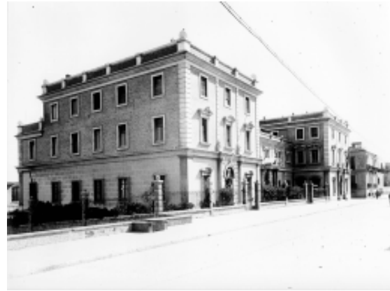
Figura 2. Edificio del Laboratorio Oceanográfico, Acuario y Museo Oceanográfico de Málaga construido a partir de 1929 en el Paseo de la Farola. Archivo Laboratorio Oceanográfico. IEO.
