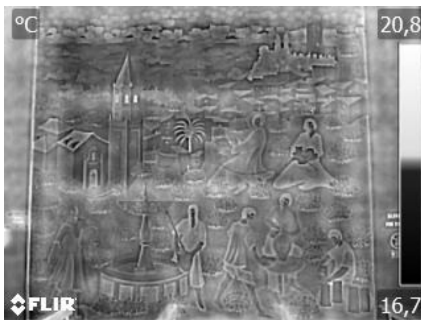
Figura 109: Fotografía infrarroja del muro 5 con la alarma “Humedad”. Fuente: Realización propia con cámara infrarroja FLIR E75 el día 24 de abril de 2025 a las 17:00 horas.
