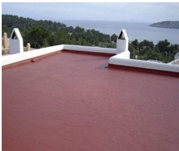
Figura 40: Fotografía de una cubierta en la que se ha aplicado un producto impermeabilizante.
