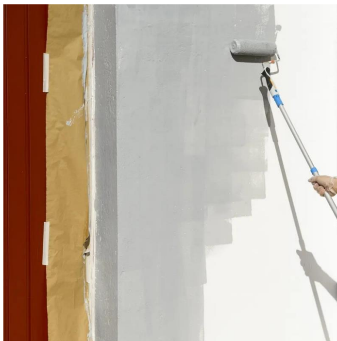
Figura 41: Fotografía del proceso de aplicación de un producto impermeabilizante en fachada.
