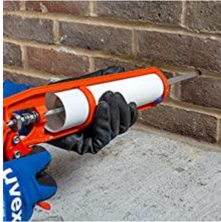
Figura 38: Fotografía de proceso de inyección química usando pistola de cartuchos de sellado. Fuente: Página oficial de DRYZONE.
