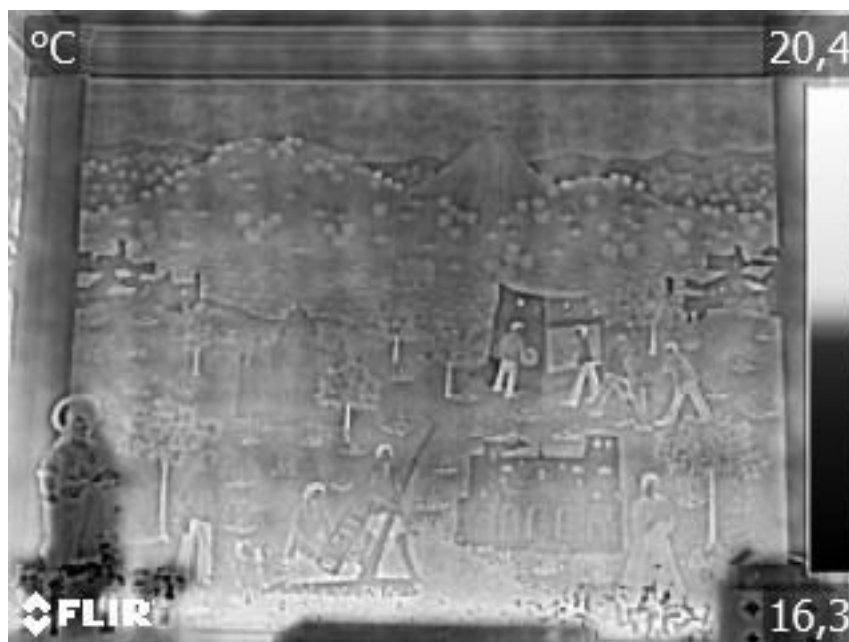
Figura 110:Fotografía infrarroja del muro 10 con la alarma “Humedad”. Fuente: Realización propia con cámara infrarroja FLIR E75 el día 15 de abril de 2025 a las 10:00 horas.
