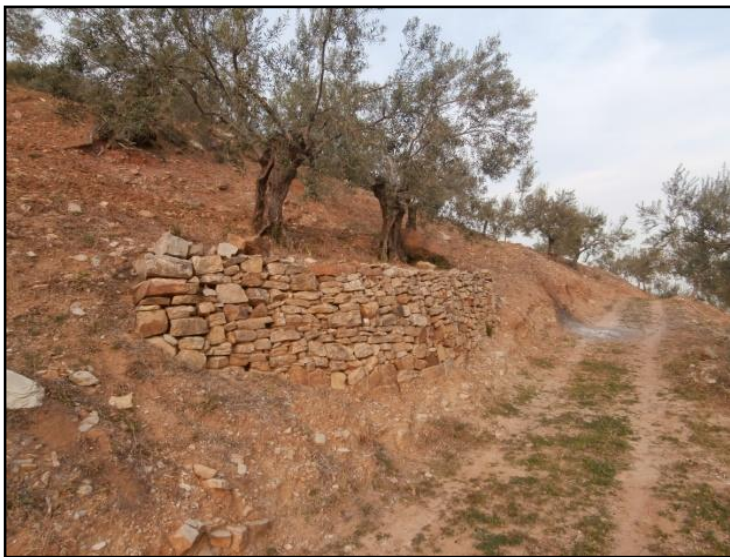
Foto 15. Muros de contención
