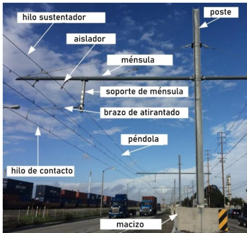
Figura 6. La catenaria y sus partes. [16]
