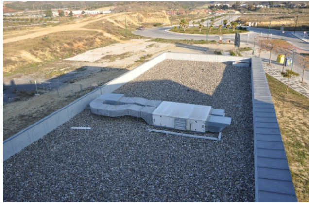
Figura 24: Recuperador de calor cruzado. Fuente: [36]
