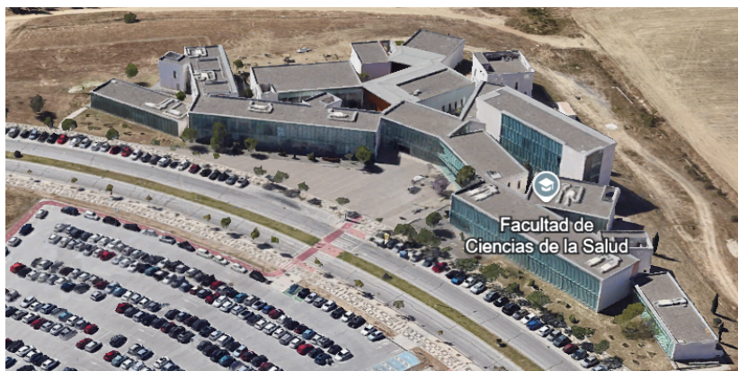
Figura 22: Edificio Ciencias de la Salud. Fuente: Google Earth
