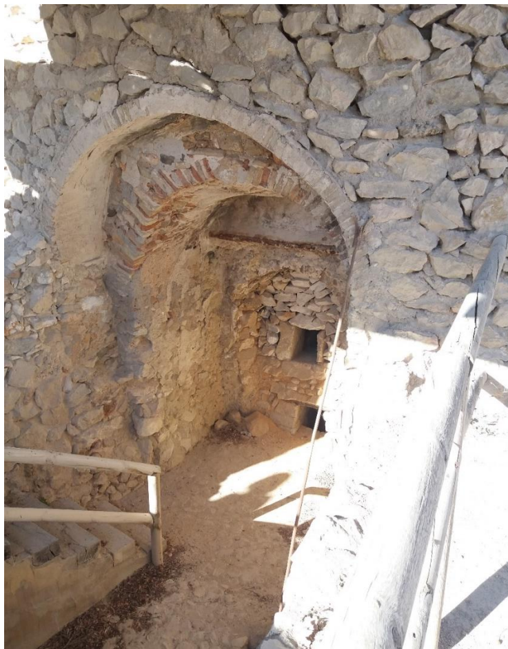
Figura 52. Zona de alimentación del horno, Museo Cal de Morón. Fuente: elaboración propia.
