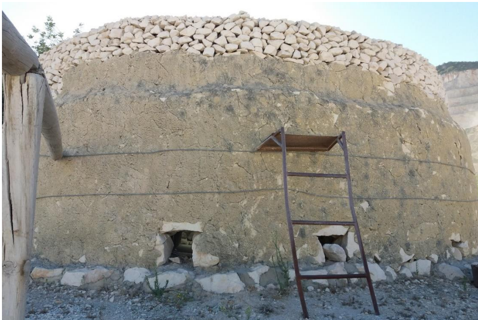
Figura 43. Exterior del horno de cal, Museo Cal de Morón. Fuente: Elaboración propia.
