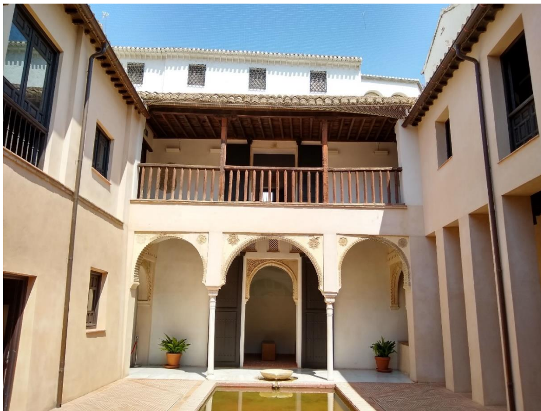
Figura 3. Centro de Interpretación Casa de Zafra. Fuente: elaboración propia.
