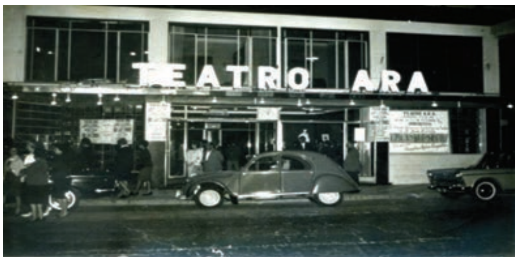
Fig.20. Fotografía de la fachada del Teatro ARA.
