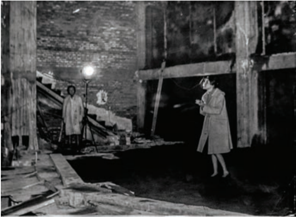
Fig.19. Fotografía de ensayo en el Teatro ARA durante las obras de construcción. Fotografía cedida por José Luís Lobera.
