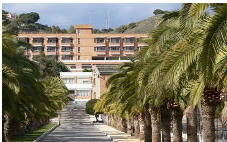
Figura 3. Imagen del edificio de Educación Secundaria Obligatoria del C.D.P “Los Olivos” (C.D.P. Los Olivos, 2009)
