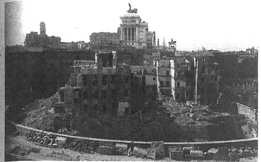
5. Foros Imperiales. Demoliciones, año 1929.
