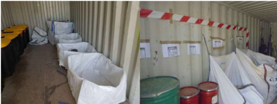
Ilustración III – Almacén de residuos peligrosos en contenedor cerrado
