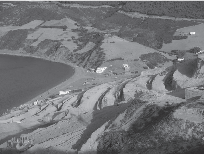
Photo 5. Aménagement du terrain pour construire un complexe touristique Cliché : J. M. Crespo Guerrero
