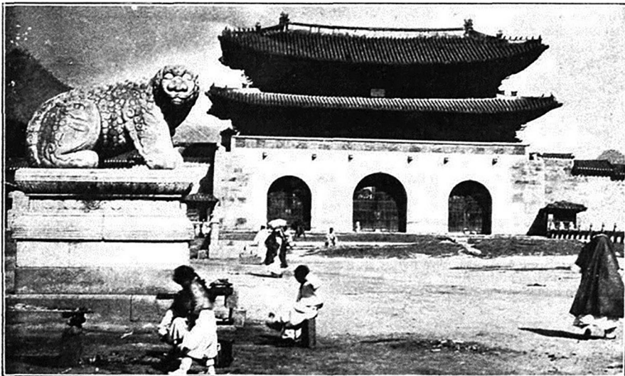
ANTIGUA PUERTA DE SEÚL, CONTIGUA AL PALACIO DE LOS SOBERANOS DE COREA
