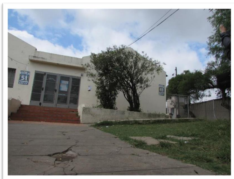
Imagen N° 6 - Entrada y edificio escolar de la Escuela Primaria N° 51 y la Escuela Secundaria N° 47, Villa Carcova. Fuente: CEDESI (2019)
