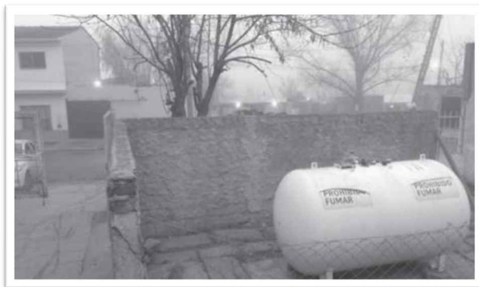
Imagen N° 38 - Fotografía de la entrada de la escuela donde está ubicado el tubo de gas y donde se puede observar el muro que ha sido construido (2018).
