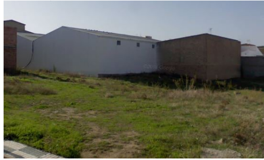
Figura 69. Visualización lateral de cubiertas (Fuente: Google Maps).
