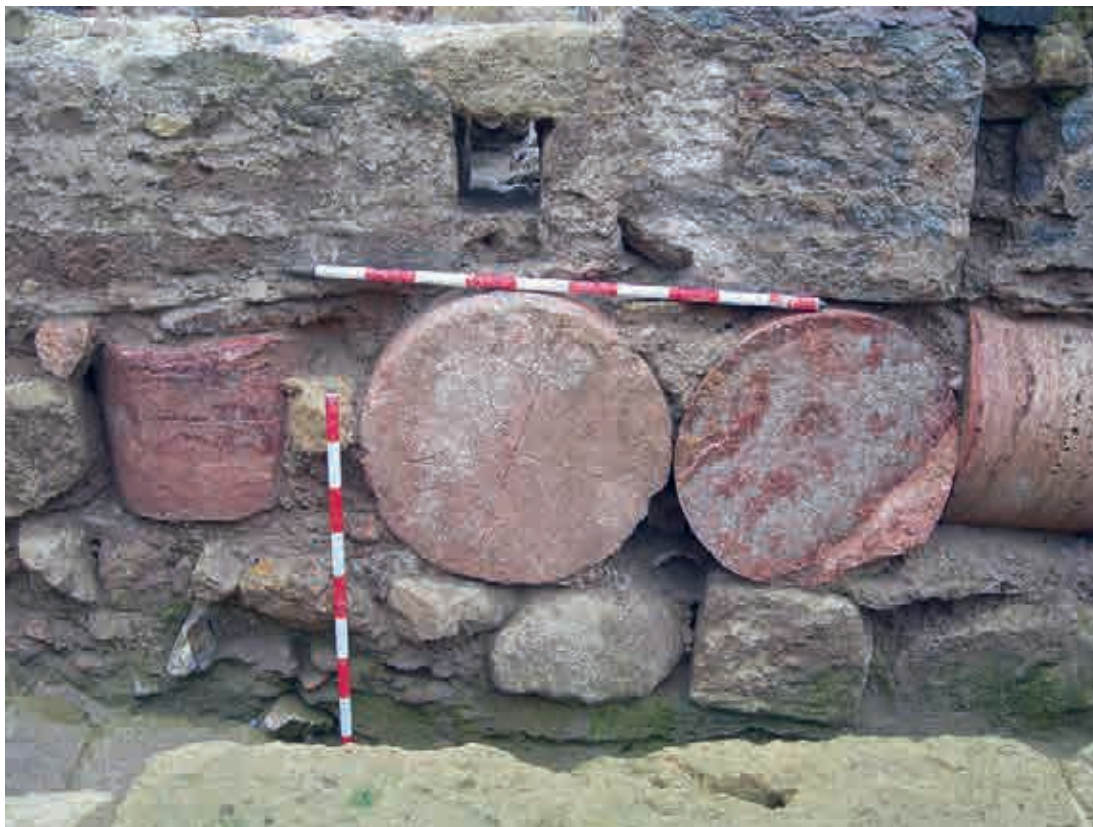
FIG. 8. — Cimentación de una taberna del mercado-almacén de Carthago Spartaria .
