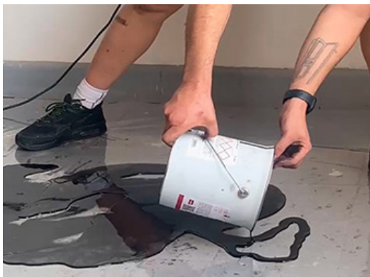
Figura 39. Detalle de vertido doble cubriente.
