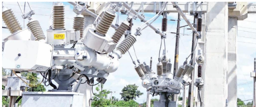
Ilustración 6. Módulo Y1 PASS M00 72.5 kV. Fuente: Catálogo ABB.
