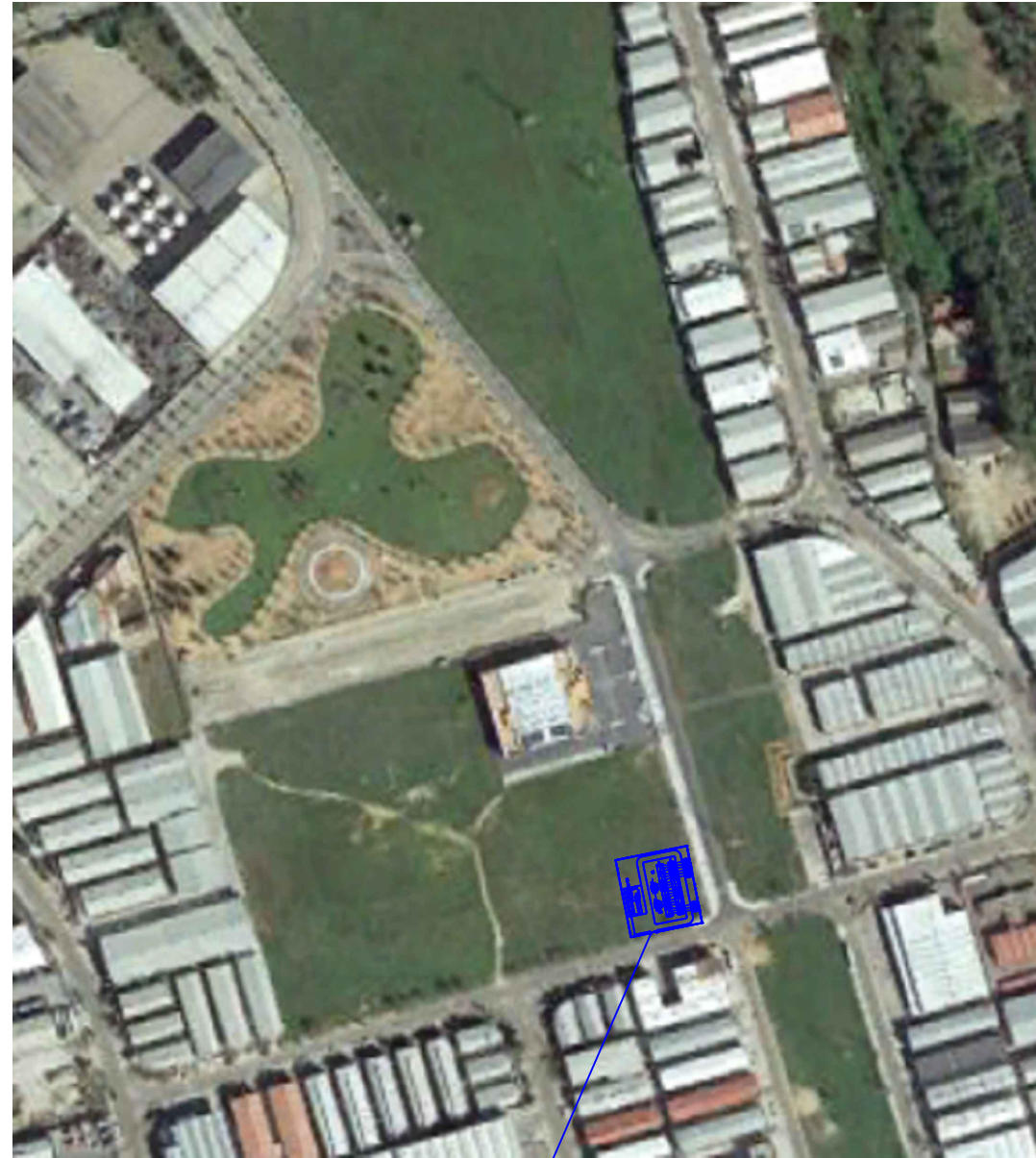
SUBESTACIÓN "LAS QUEMADAS"
