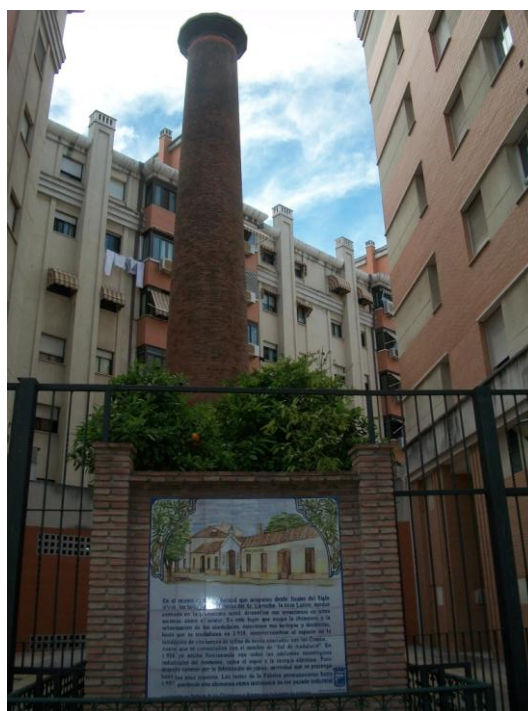
Fig. 15. Chimenea de la calle Constancia. Foto: Sandra Calderón.
