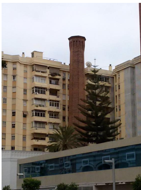
Fig. 13. Chimenea Calle Maestranza. Foto: Sandra Calderón
