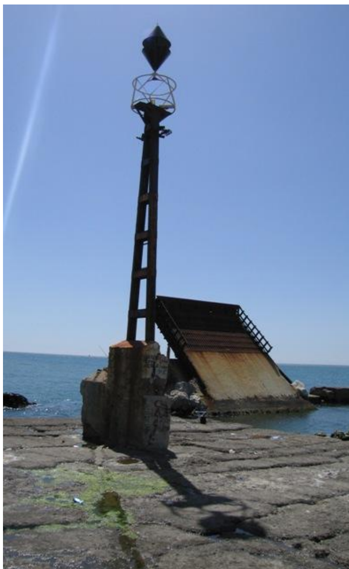
Fig. 34. Espigón de la Térmica. ( http://eldiariodesu.blogspot.com.es/2011/03/las-chimeneas-de-las-antiguas-fabricas.html ). Recuperado el 21/06/2013
