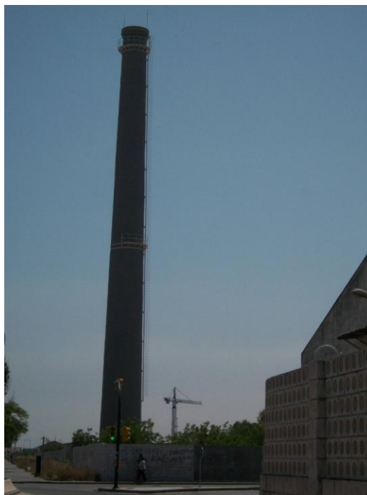
Fig. 25. Chimenea de la Térmica. Foto: Sandra Calderón
