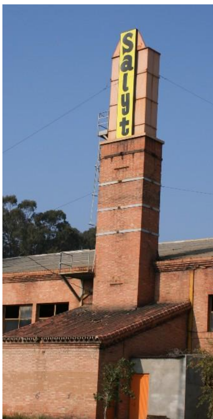
Fig. 29. Chimenea de SALYT. ( http://eldiariodesu.blogspot.com.es/2011/03/las-chimeneas-de-las-antiguas-fabricas.html ). Recuperado el 21/06/2013
