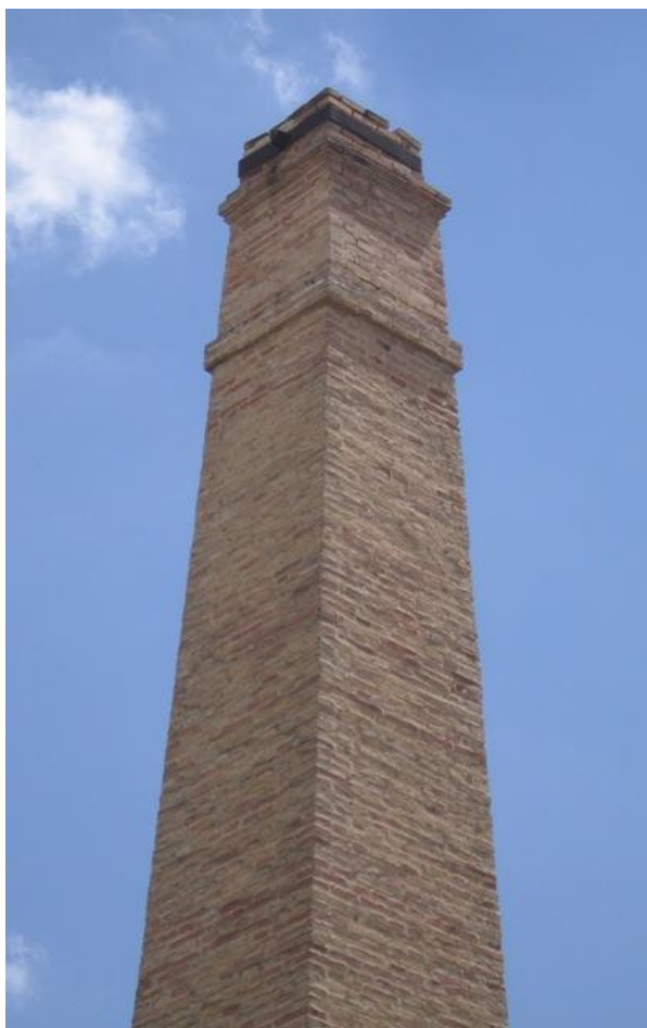
Fig. 26. Chimenea de la fábrica de Aceites de Santa María.
