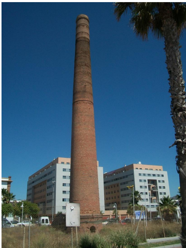
Fig. 23. Chimenea de la Cross. Foto: Sandra Calderón
