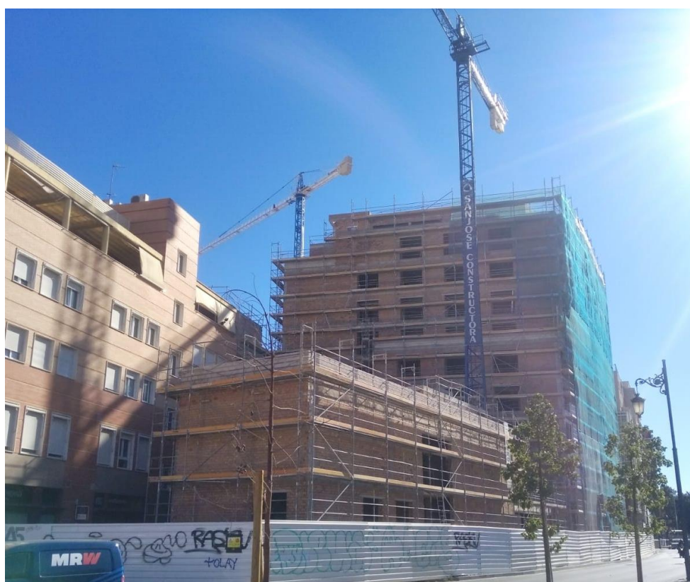
Figura 19. Hotel H10 Croma Málaga en construcción (conocido coloquialmente como “hotel de Moneo”)
