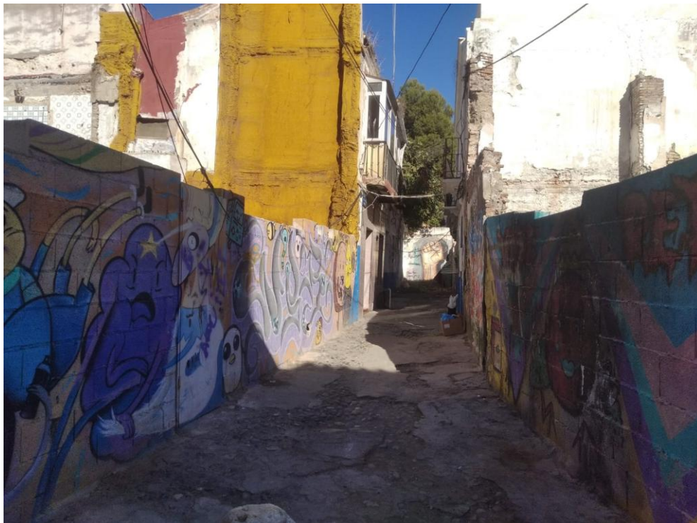
Figura 31. Manzana demolida en una zona vulnerable al norte del Centro Histórico de la ciudad. Zona Lagunillas.
