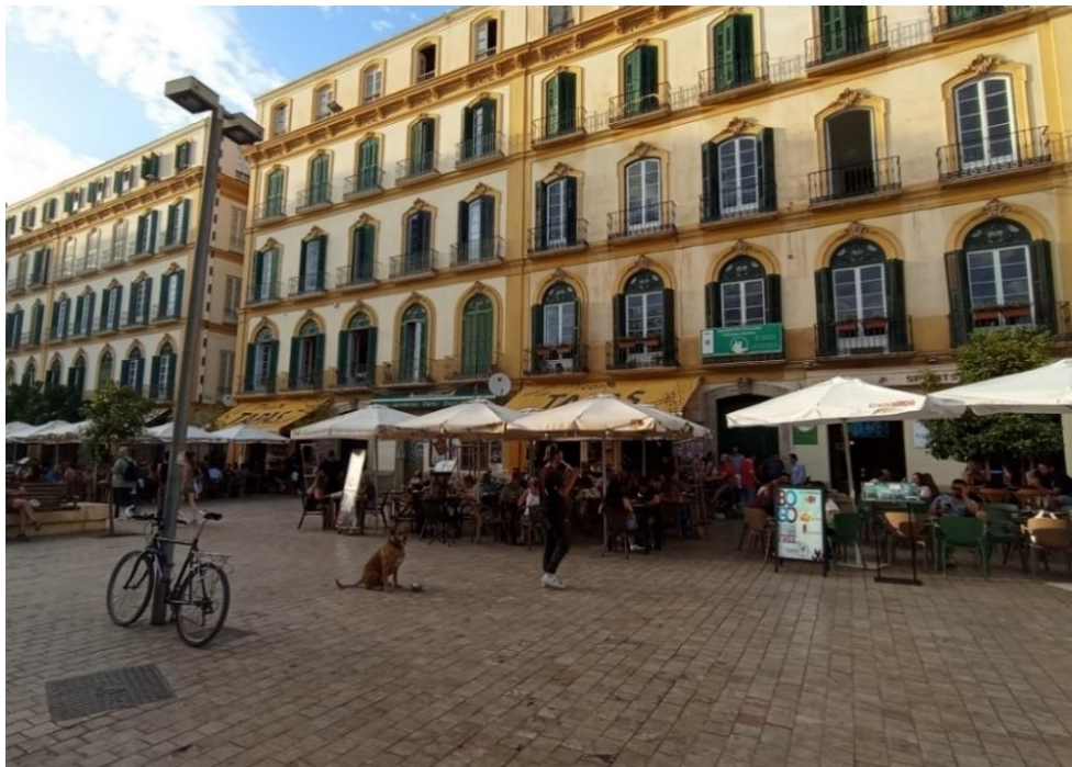
Figura 30. Área dedicada a la hostelería en el extremo norte del Centro Histórico. Plaza de la Merced
