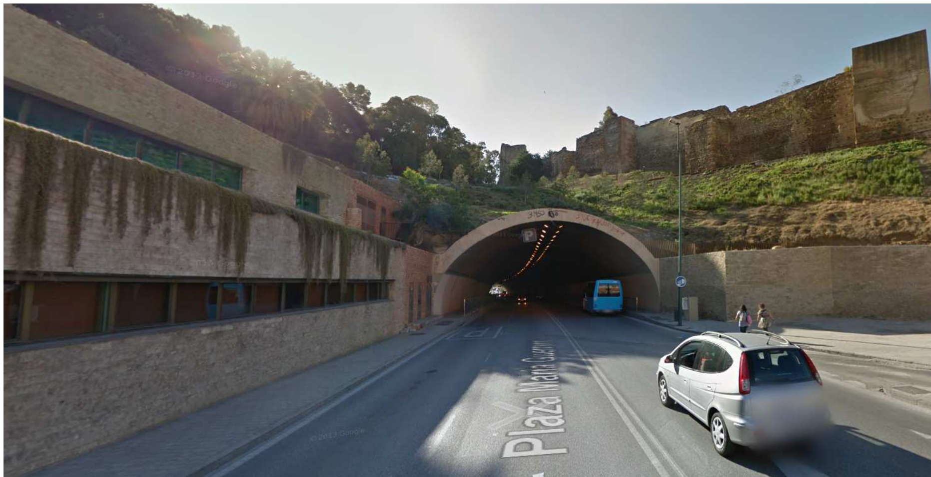
Figura 7. Imagen del túnel desde Google Street View
