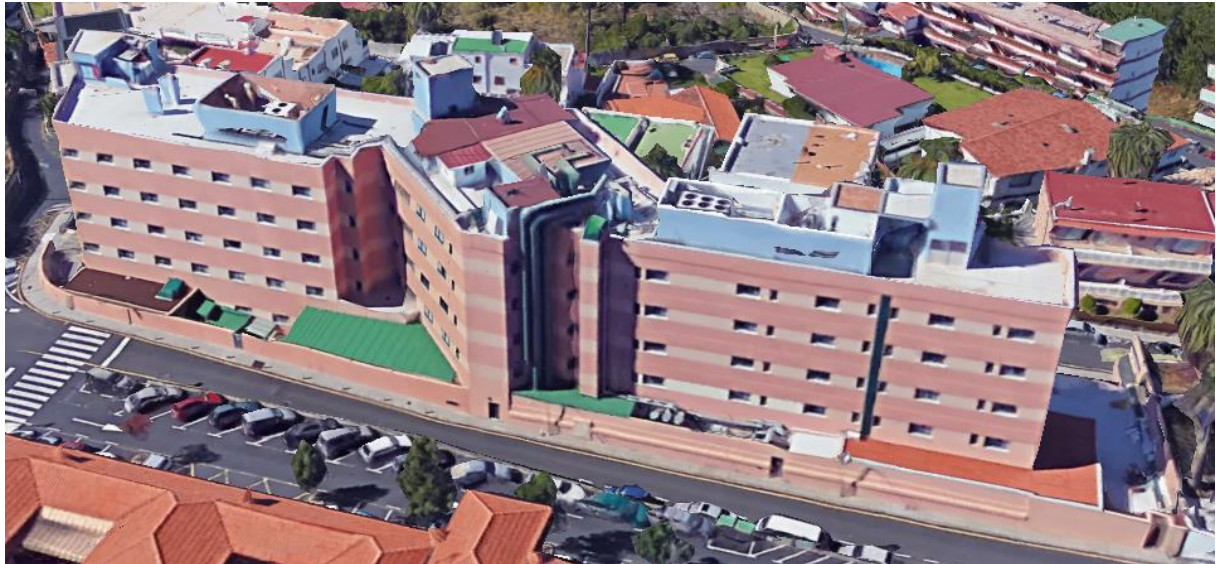
Figura 16. Vista del Hospital Universitario Hospiten Bellevue. Fachada sur (fuente: Google Earth).
