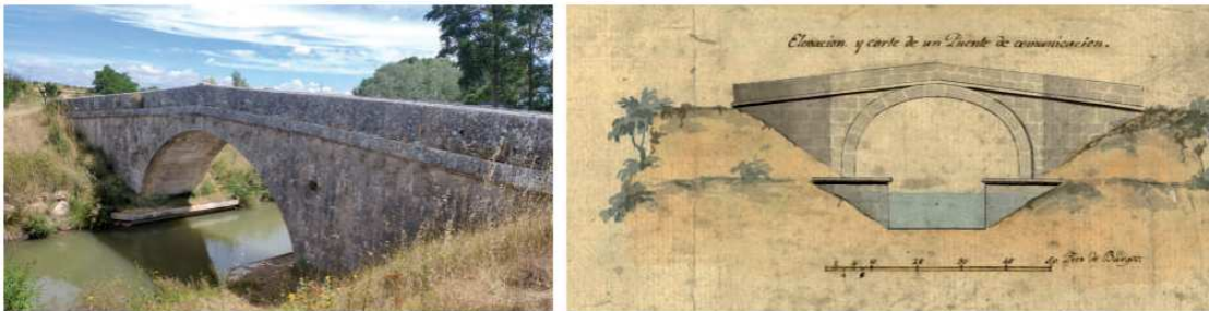
Figura 1: Puente de Carracalzada en el canal de Castilla.
