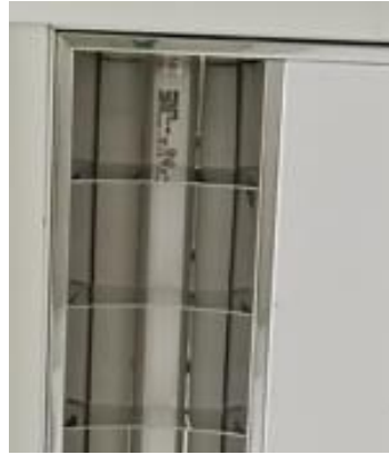
Figura 46. Lámpara Philips MASTER TL5 14W
