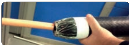
El cuerpo de la junta lleva integrado el blindaje y la funda externa
