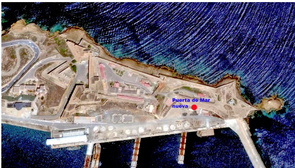
Fig. 13. Situación de la nueva puerta de Mar. Elaboración propia sobre una toma de Google Earth.
