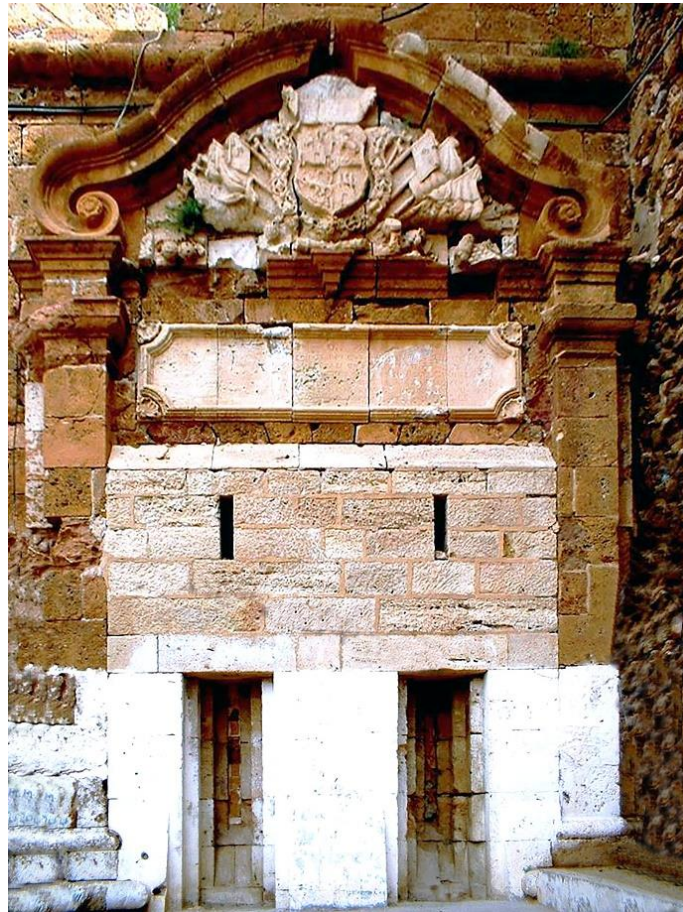
Fig. 23. Vista de la puerta nueva de Tierra.
