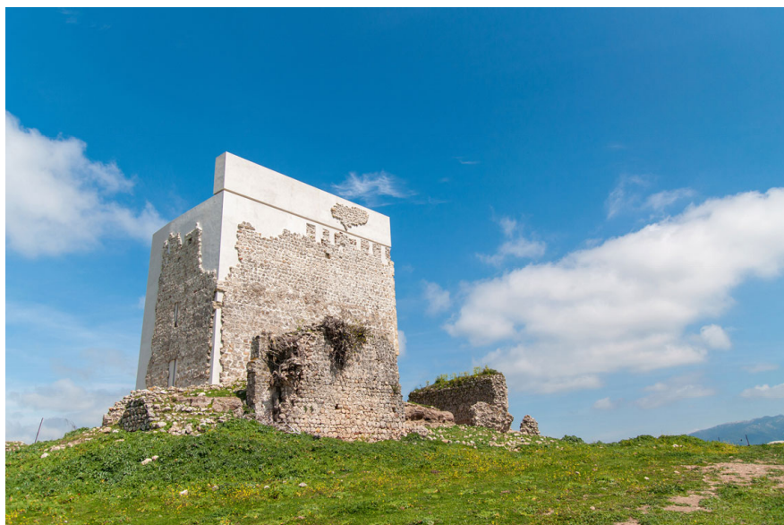
Figura 4. La Torre de Matrera una vez terminada la rehabilitación.
