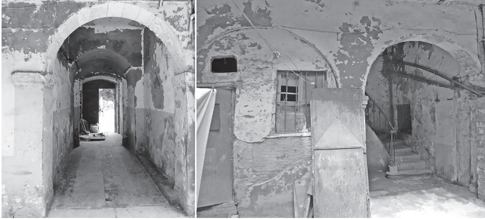
Fig. 8. Composición del pasillo y patio interior del bloque de edificios en la fachada oeste de la plaza. Las arcadas son fruto de las obras de adaptación de fachadas a la nueva alineación. Fotografía de los autores.
