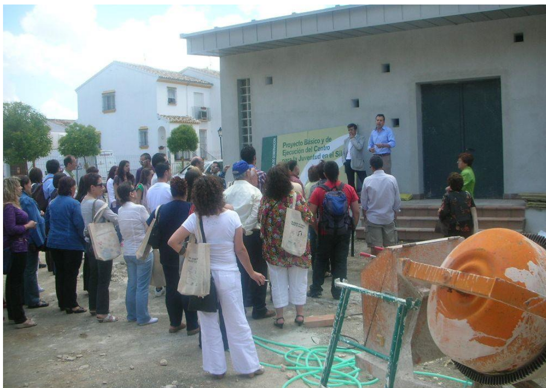
Imagen 18. Visita a las obras de El Silo, impulsado por dinámicas participativas.
