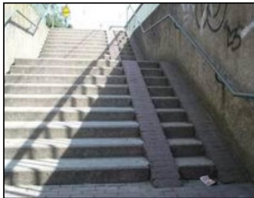
Figura 51: Rampas para el acceso a una estación de metro. Fuente: Ayuntamiento de Madrid, 2008.
