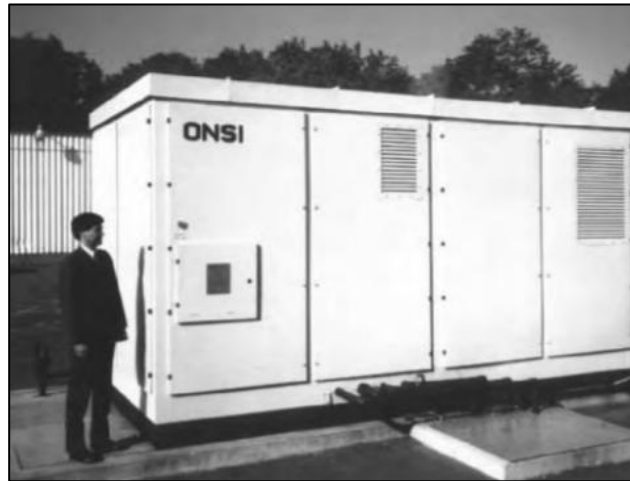
Figura 22. Sistema de cogeneración PAFC 200-kW. Fuente: [13]
