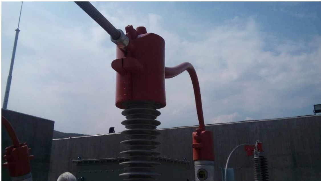
Figura 30. Imagen del SPSF6 montado en Bulgaria en 2019 (EnverTec, 2014)
