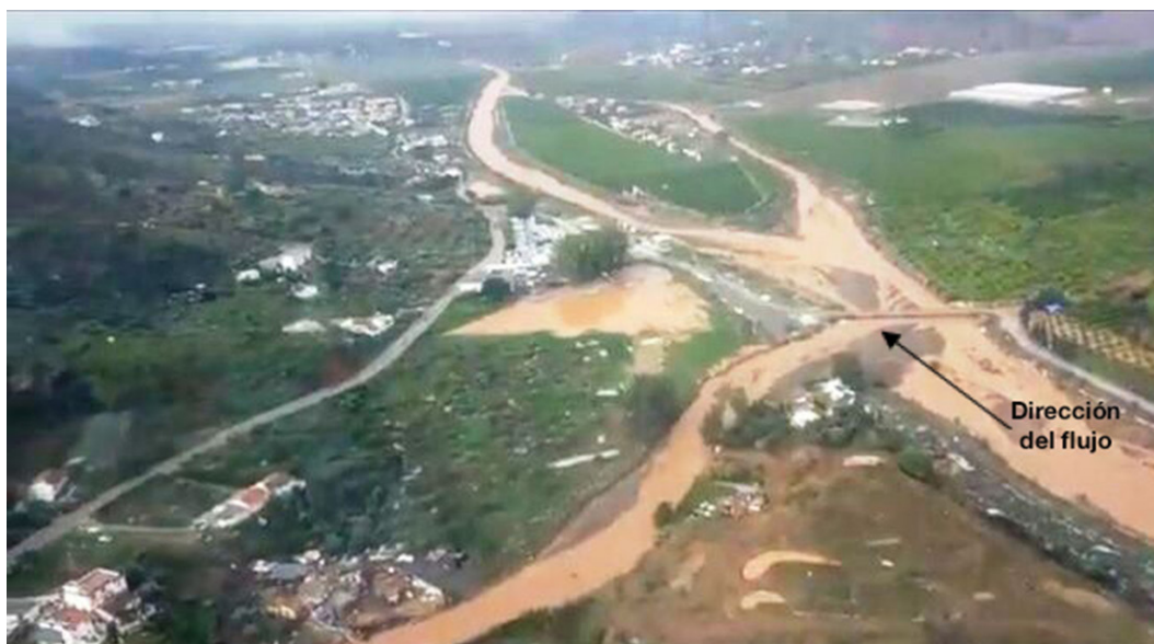
Figura 9. Imagen aérea del puente de la carretera A-7058 sobre el río Campanillas, el día 30 de enero de 2020
