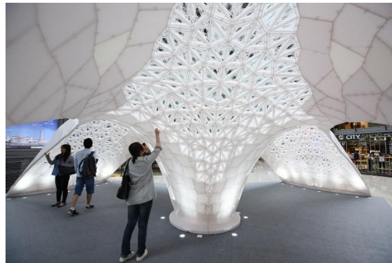
Figura 19: Estructura fabricada mediante FA. [14]
