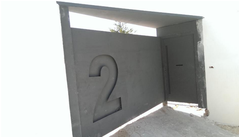
Ilustración 16 Portón exterior Comunidad de Viviendas (Aportada por Cerrajería Moli)
