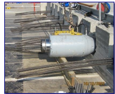
Figura 13. Proceso de tesado de las armaduras
