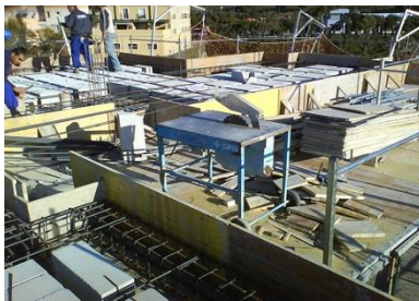
a) Trabajos de carpintería para la construcción de encofrados
