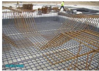
b) Colocación de armaduras
