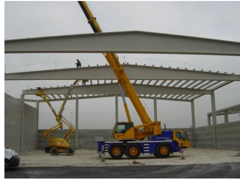
Figura 24. Estructura con todos sus elementos prefabricados (pilares, vigas y correas)
