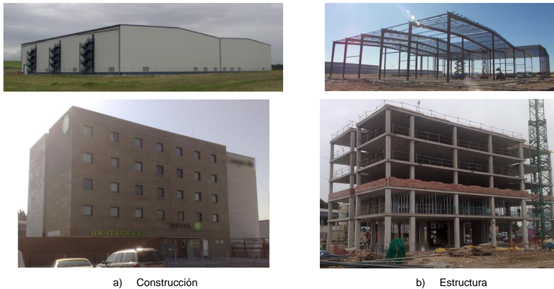
Figura 1. Construcción y su estructura
