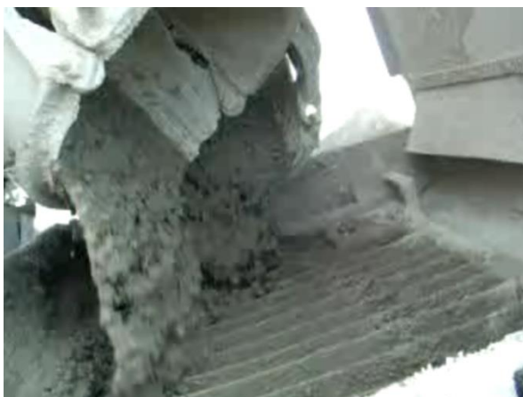
Figura 4. Hormigón en estado fresco, durante un proceso de Hormigonado.
