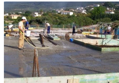
c) Curado del hormigón
