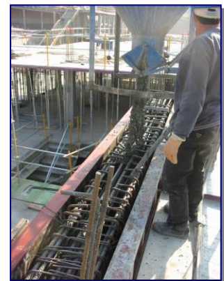
Figura 7. Ejecución de un elemento de HA
