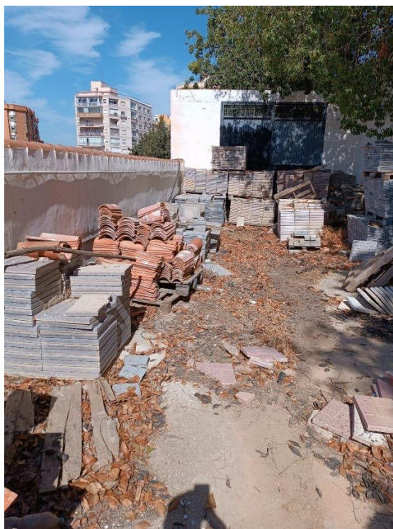
Ilustración 61. Zona de solerías.
