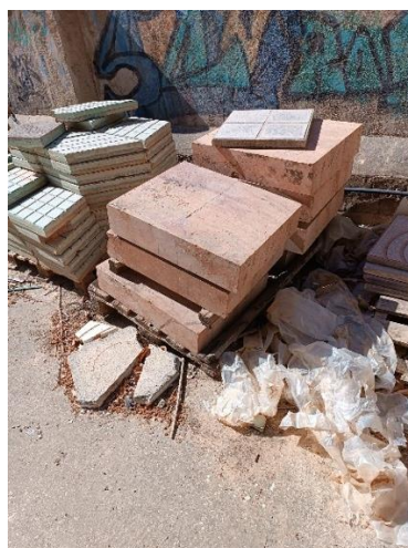
Ilustración 63. Zona de solerías. Ejemplo de losas de calle Larios.
