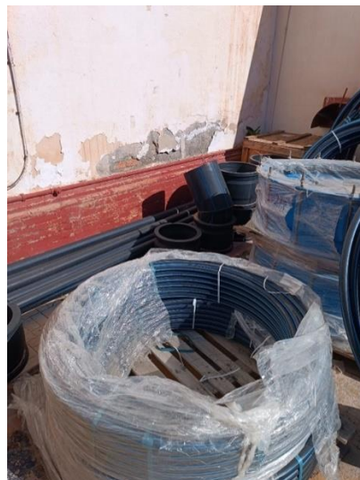
Ilustración 40. Acopio de tubo de polietileno. Sin estrenar.
