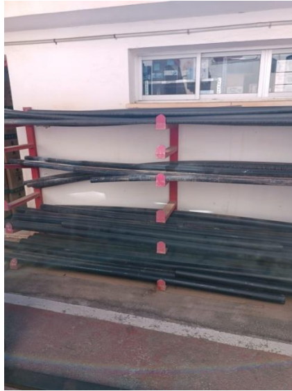
Ilustración 41. Acopio de tubo de PVC. Lateral.
