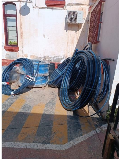
Ilustración 39. Acopio de tubo de polietileno.
