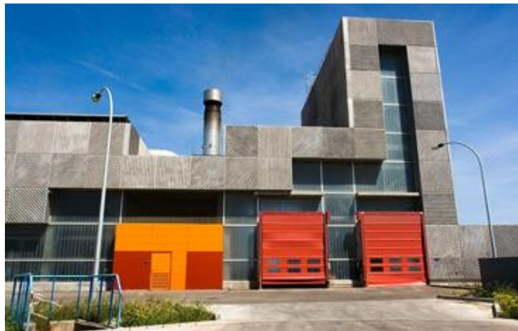
Ilustración 4. Sede EDAR Guadalhorce.
