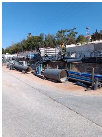
Ilustración 58. Zona de tuberías. Algunos carretes sueltos.
