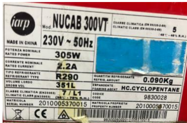
Ilustración 11. Placa de características de vitrina refrigerada.
