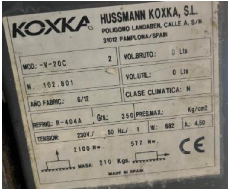
Ilustración 12. Placa de características de isla frigorífica.
