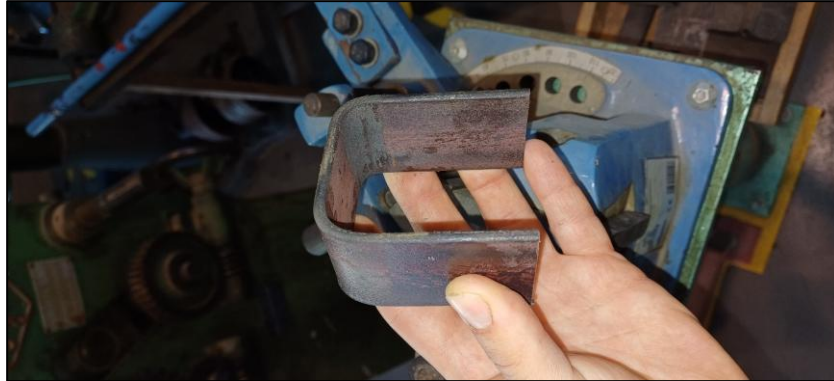
Figura 51. (a) Corte de las pletinas, (b) Doblado de las pletinas, (c) Soportes terminados.
