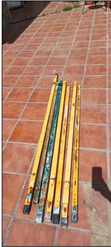
Figura 7. Estado inicial de los perfiles de la estructura.
