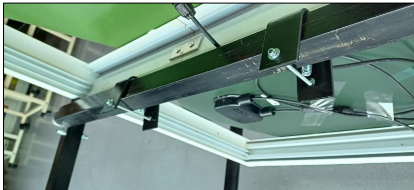
Figura 58. Resultado del montaje de soportes.
