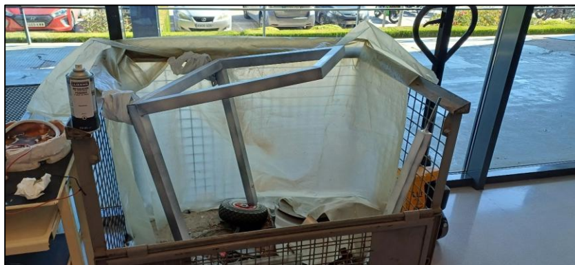
Figura 44. Pintado con imprimación de la estructura.
